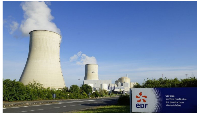
Centrale de Civaux. Dans le projet du gouvernement, le coût vertigineux de remise en état du parc nucléaire pourrait être mis à la charge du contribuable.
