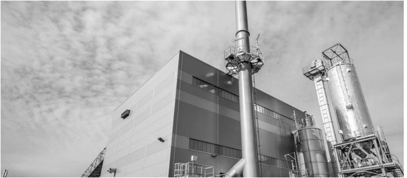
Une centrale biomasse. La production d'énergie à partir du bois est une filière insuffisamment valorisée en France.
